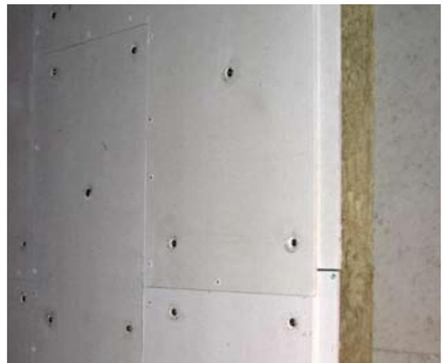
Рис.1 Схема монтажа сэндвич-панелей ЗИПС
