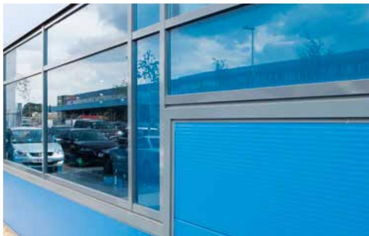
Примыкание панели к оконному проему
