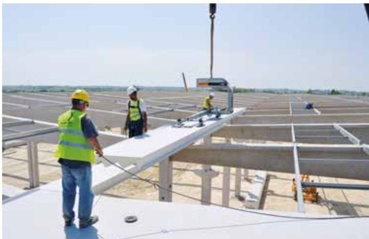
Большепролетная панель X-DEK (пролет до 6 м)
