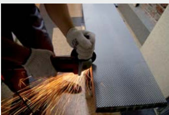
Раскрой панелей Саундлюкс посредством дисковой пилы по металлу и ножа
