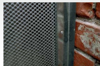
Крепление панели к стене и монтаж П-профиля
