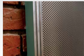
Стык панелей, использование \Omega -профиля
