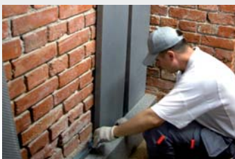
Установка панелей в каркас, стыковка и фиксация панелей на стене
