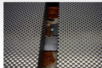
Установка панелей в каркас, стыковка и фиксация панелей на стене
