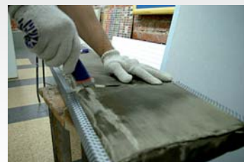
Раскрой панелей Саундлюкс посредством дисковой пилы по металлу и ножа
