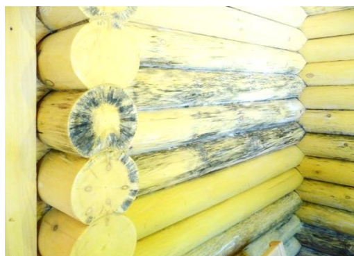
Пораженная грибами древесина стен дома
